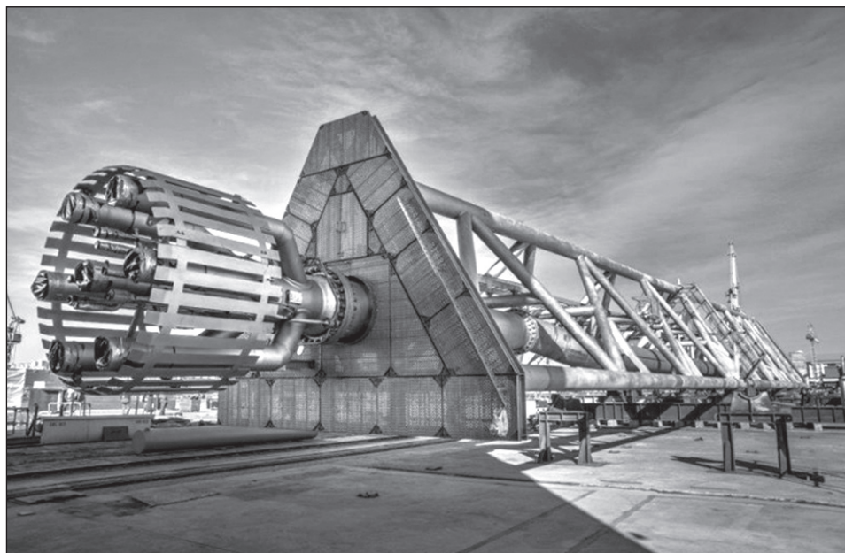
Rys. 3. 250-tonowy moduł wieży spalania gazów powstających podczas wydobywania ropy dla platformy EldFisk, wykonany w Vistal Gdynia SA.
