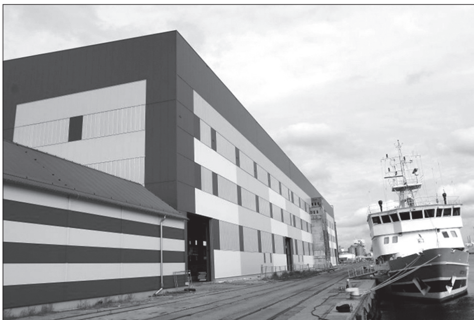
Rys. 2. Nowa hala stoczni Vistal Gdynia SA przeznaczona jest do realizacji najbardziej złożonych, wielkogabarytowych konstrukcji stalowych głównie dla segmentu offshore i marine.
