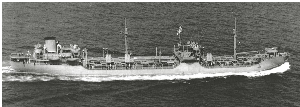
Rys. 2. Przekonwertowany z tankowca statek kontenerowy S/S Ideal X.
