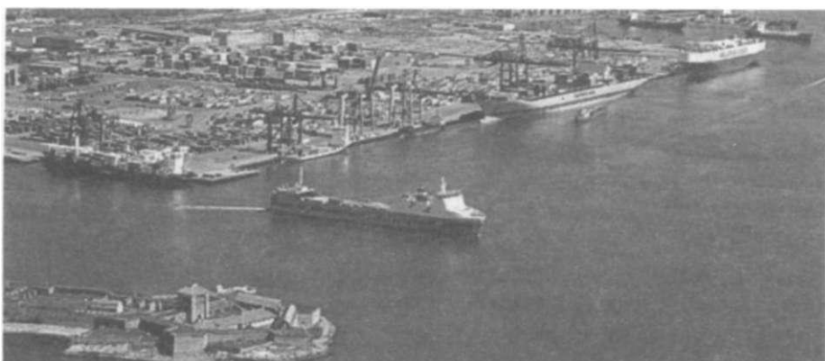
Rys. 5. Terminal kontenerowy w Goeteborgu
